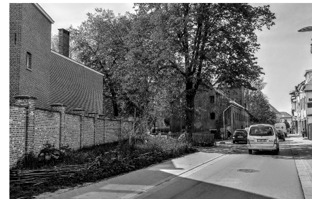
Foto Stationsstraat - bestaande toestand
